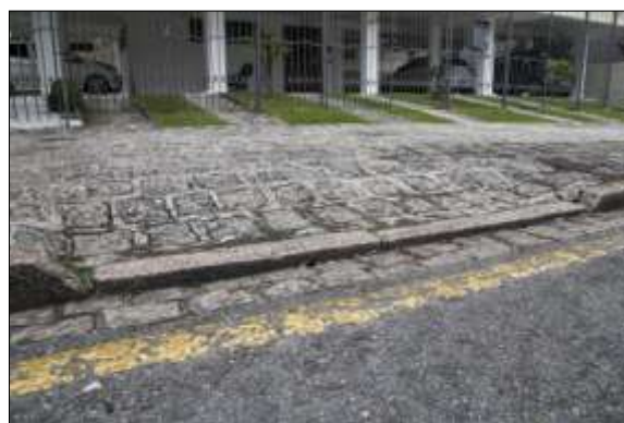
Figura 5 – Exemplo de rebaixamento de meio-fio para acesso ao lote.
