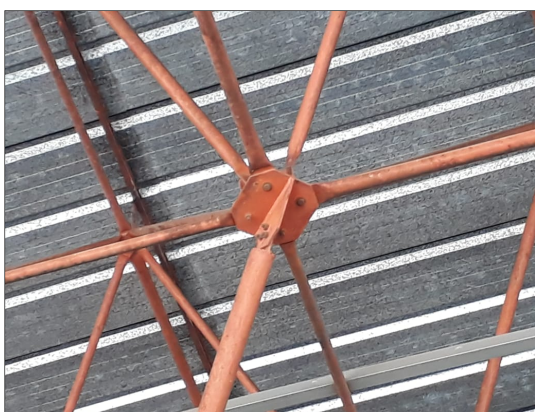
Figura 5 – Detalhe do nó da estrutura espacial
