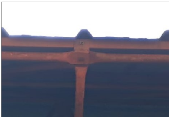
Figura 7 – Detalhe da ligação entre o telhado e a estrutura espacial
