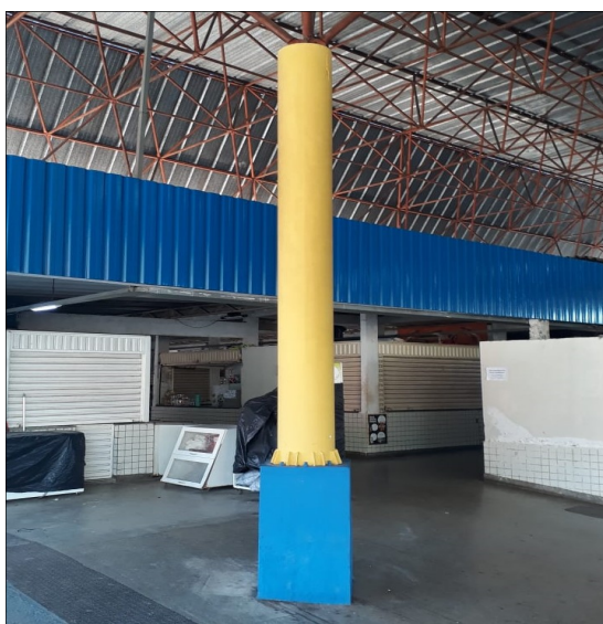
Figura 3 – Coluna de suporte da estrutura espacial Figura 4 – Detalhe da união da base da coluna metálica
