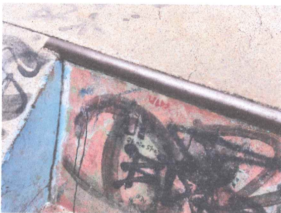
FOTO - 10: VISTA INTERNA – QUINAS METÁLICAS ARREDONDADAS.
