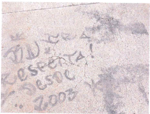
FOTO - 8: VISTA INTERNA – FISSURA TREXO DE APROX 50cm x 50cm
