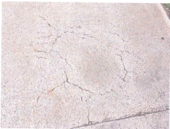
FOTO - 6: VISTA INTERNA – FISSURA TREXO DE APROX. 50 cm x 50 cm
