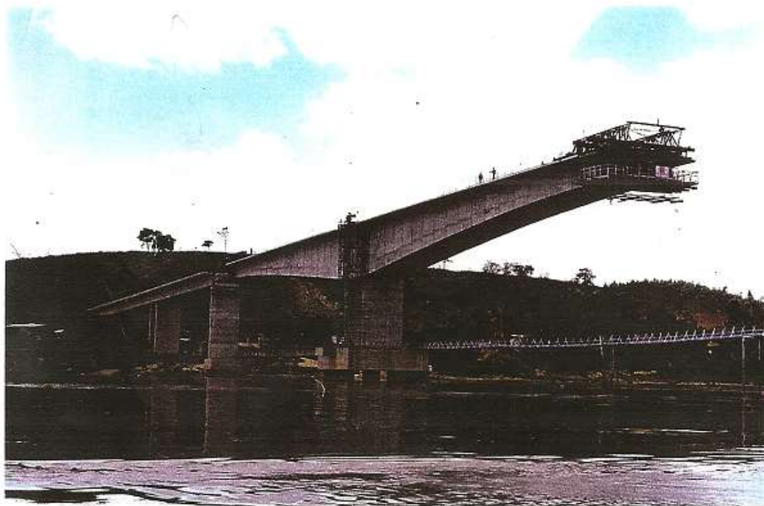
VISTA DO BALANÇO SUCESSIVO NO PILAR 3
