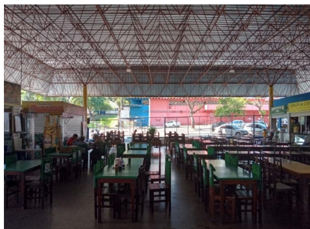
Foto 8: Vista interna da feira – Estrutura central existente, em bom estado de conservação. Apenas as telhas serão trocadas.
