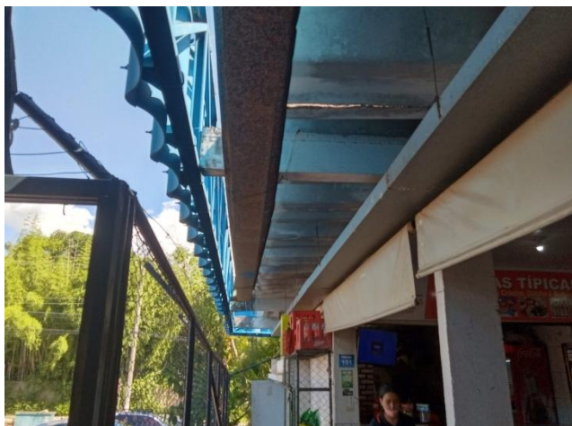
Foto 9 : Vista da calha – O sistema de captação de águas pluviais será substituído.
