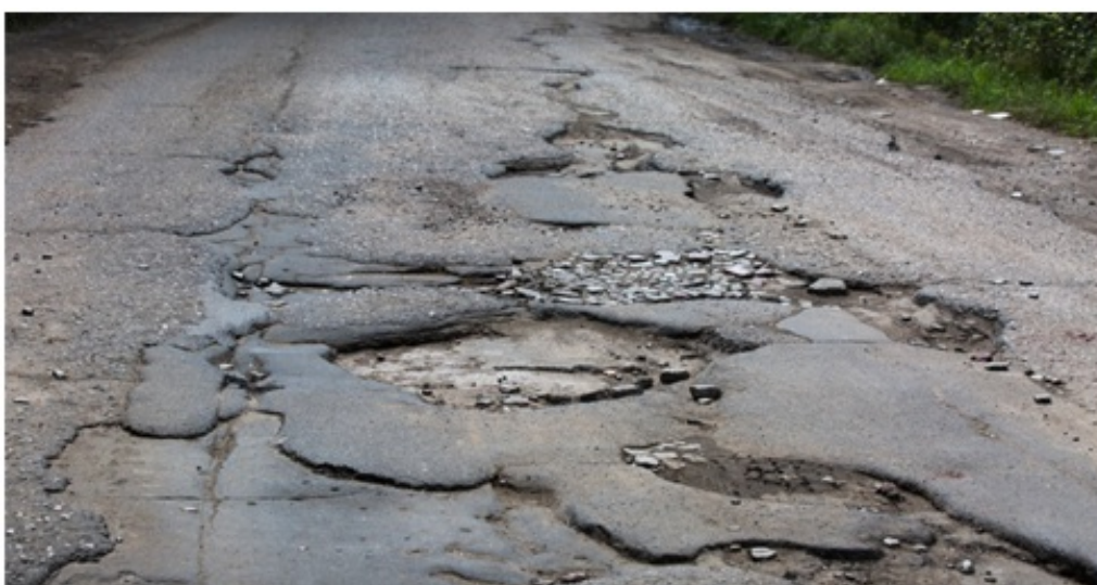
Figura 1 — Segmento com diversos defeitos, incluindo panelas e trincas
