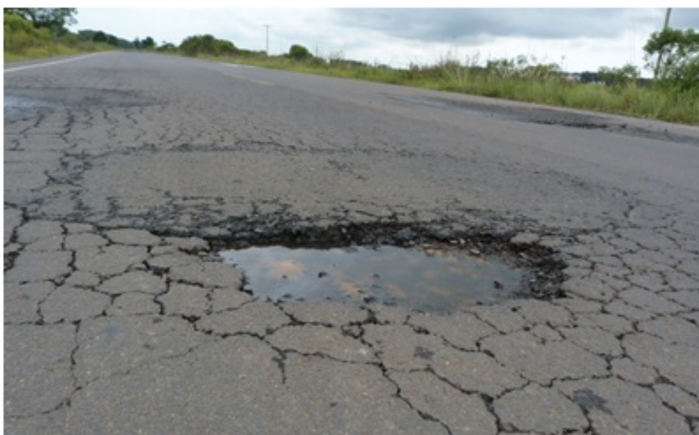
Figura 2 — Panela e área degradada ao redor da panela
