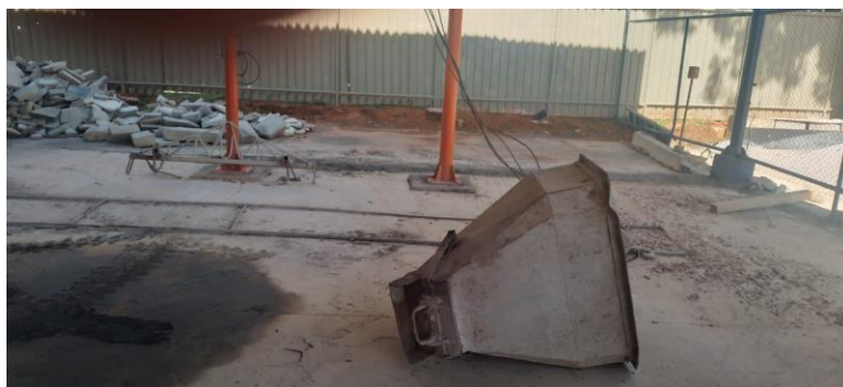
Imagem 8 – Trilhos, com o recipiente receptor de concreto. (Equip. 02)
