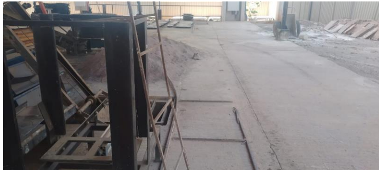
Imagem 19 – Fim dos trilhos, misturador e outros moldes. (Equip. 02)
