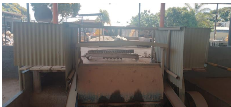
Imagem 4 – Vista para a betoneira industrial. (Equip. 01)
